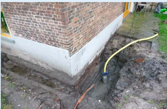
Figuur 35: Fundering op staal put boerderij Midden-Delfland (BVL Bouwadvies)
