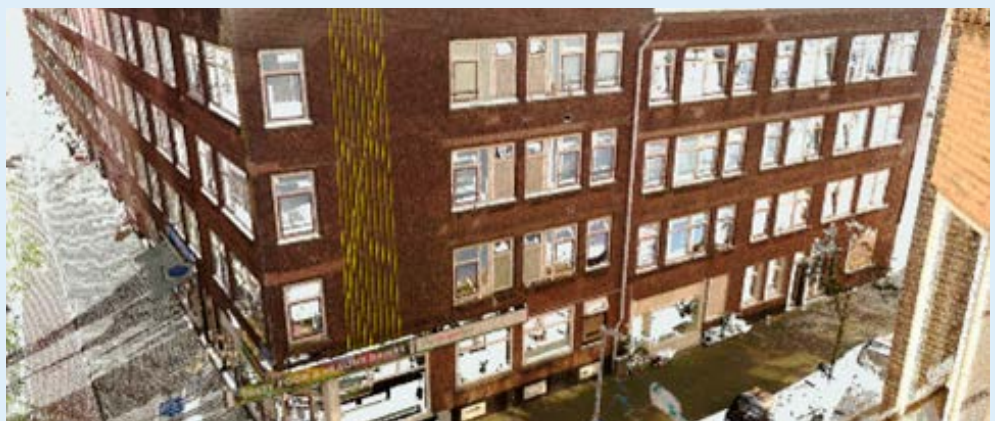
Figuur 21: Gevelscan als nieuwe techniek voor gevelinspecties (Zandbergen)
