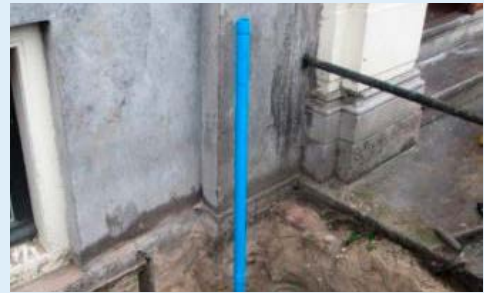
Figuur 32: Inspectieput met peilbuis voor latere lokale grondwaterstandsmeting (Aveco de Bondt)
