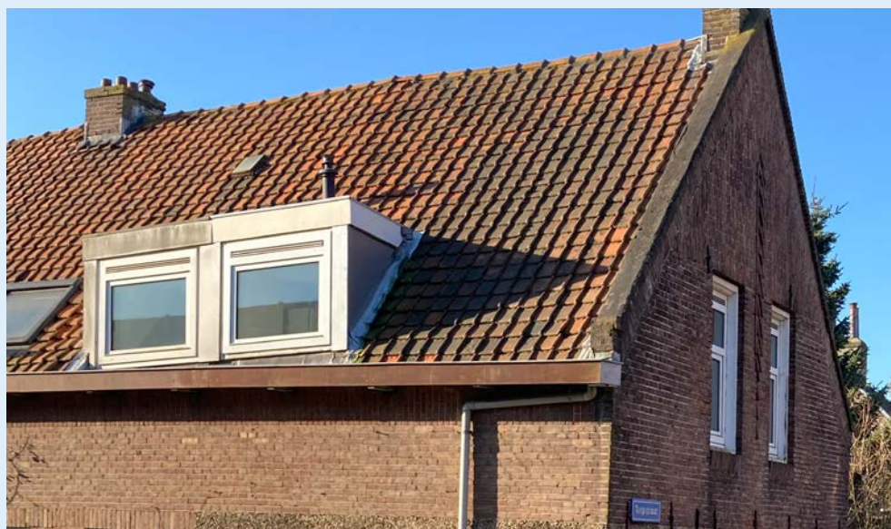
Figuur 16: Scheefstaande woning met rechte elementen (Gemeente Rotterdam)
