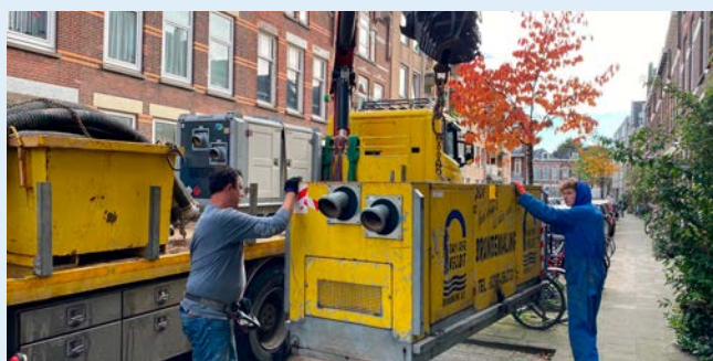
Figuur 33: Bronbemaling ten behoeve van een funderingsinspectie (BVL)
