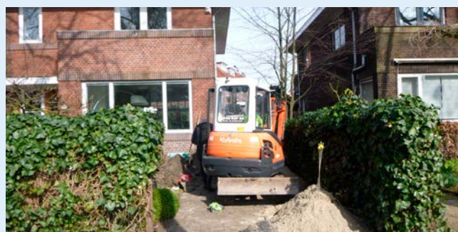
Figuur 34: Graafwerk ten behoeve van een funderingsinspectie (BVL)
