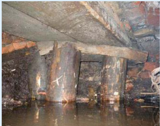
Figuur 57: Ingeknepen kesp (Fugro)
