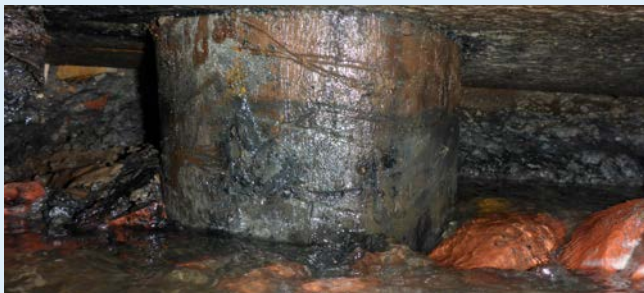
Figuur 44: Houten funderingsconstructie in goede conditie (BVL)
