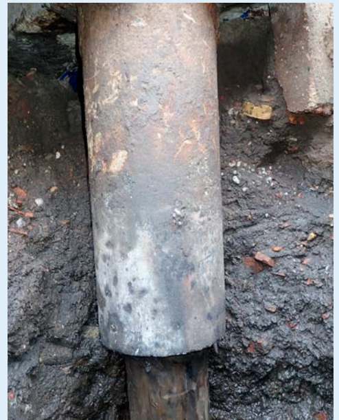
Figuur 10 en 11: Links funderingstype C: houten paalfundering onder een beton balk en rechts funderingstype D: houten paalfundering met betonopzetter (Fugro)
