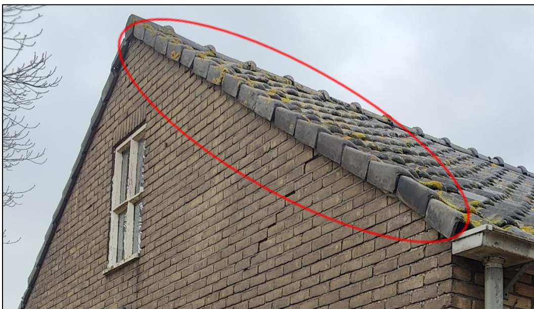
Overhangende gevelpannen en een scheur in de spouwmuur, aangeduid met de rode cirkel.
